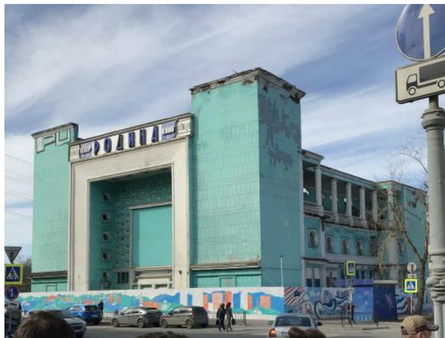
ОКН регионального значения, Здание кинотеатра «Родина», 1939 г., 1948 г., ул. Ленинградская, д. 26
